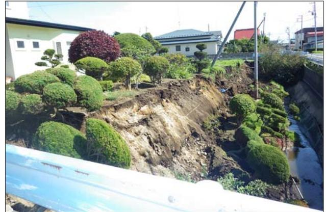
護岸が崩壊したミドリ川
