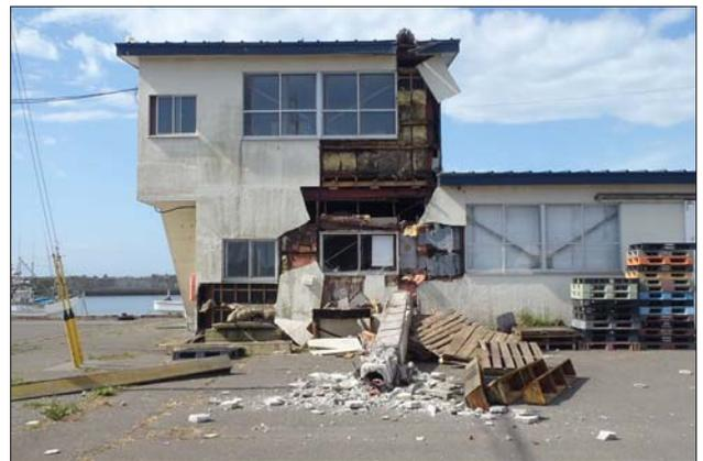
煙突・壁の一部が崩壊した漁業協同組合富浜事業所
