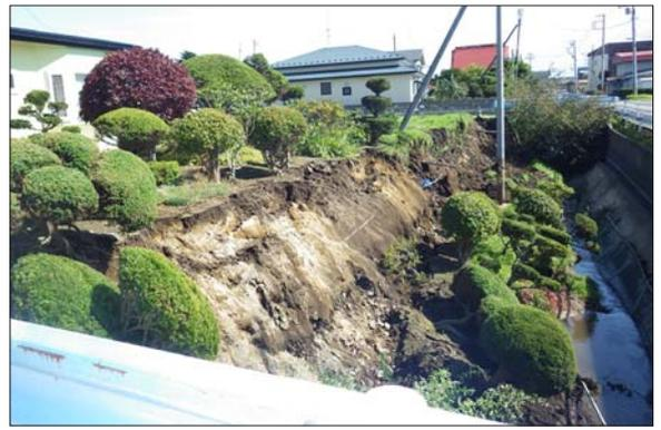
護岸が崩壊したミドリ川
