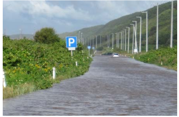
高潮により寸断された国道235号線 (豊郷～清島間)
