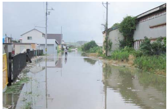
高潮により冠水した厚賀地区町道
