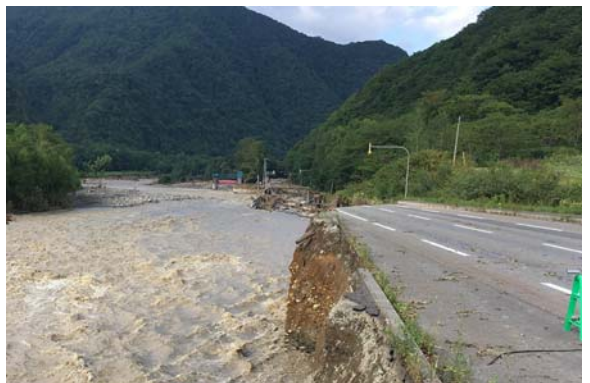
沙流川の氾濫により寸断された国道274号 (千栄～日勝峠間)
