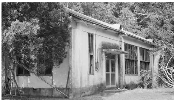
▲取り壊し予定の三和小学校
