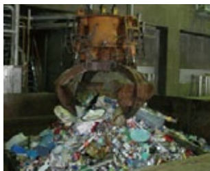
第2工場(破碎施設)
