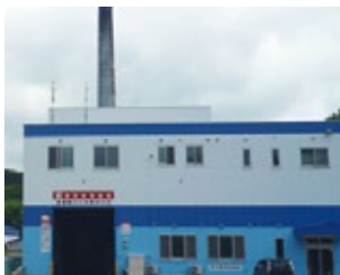
第1工場(焼却施設)
