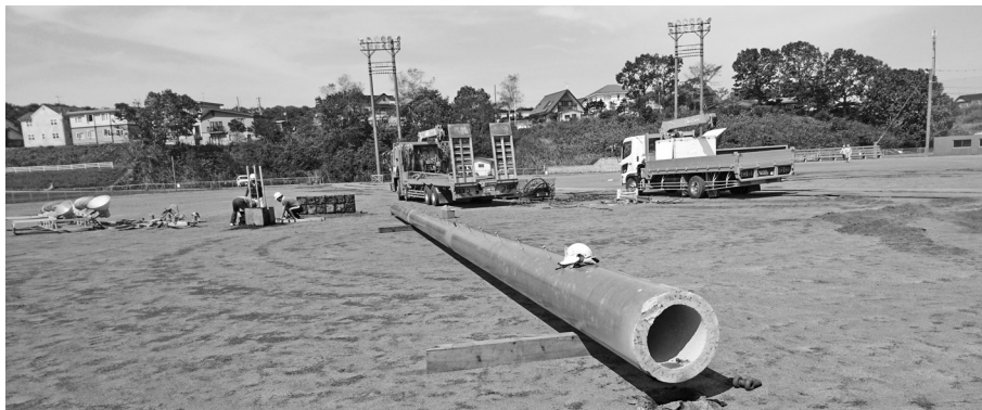
《土砂崩れ防止のための富川球場照明灯撤去工事》
