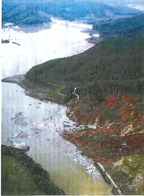
厚真ダムでも湖岸の斜面崩落で大量の土砂がダム湖に流入した = 7日午前8時45分、胆振管内厚真町管内（本社へりから、金田淳撮影）
